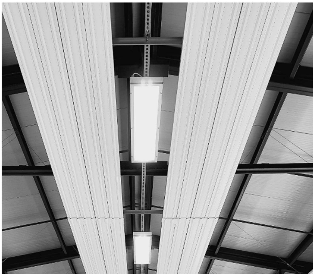
Das KIT Classic Sortiment umfasst die Standardlängen 2, 3, 4 und 6 m. Aus den Grundmodulen entstehen bei Bedarf vier Breiten von 330 mm bis 1338 mm. Hier im Bild ist ein Anwendungsbeispiel der Variante NG (no gap) in einer Industriehalle abgebildet. FOTO: RMBH
