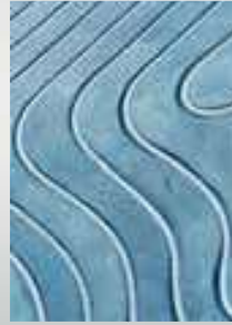
Nachträglich eingefräste Estriche
