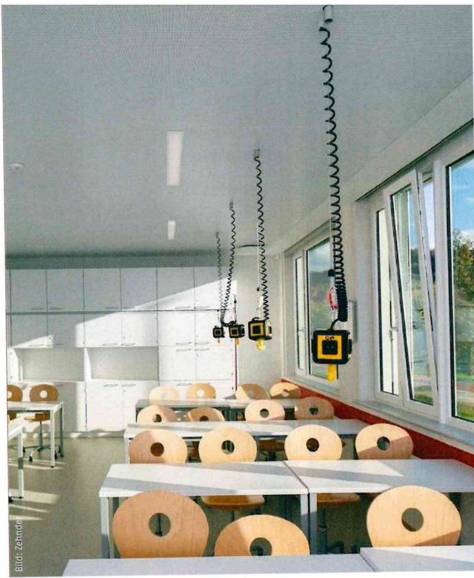
Bei der Sanierung dieser Schule fiel die Wahl auf eine geschlossene Metalldecke mit Kupfer-Aluminiumaktivierung, ausgeführt als Einhängesystem, von Zehnder.
