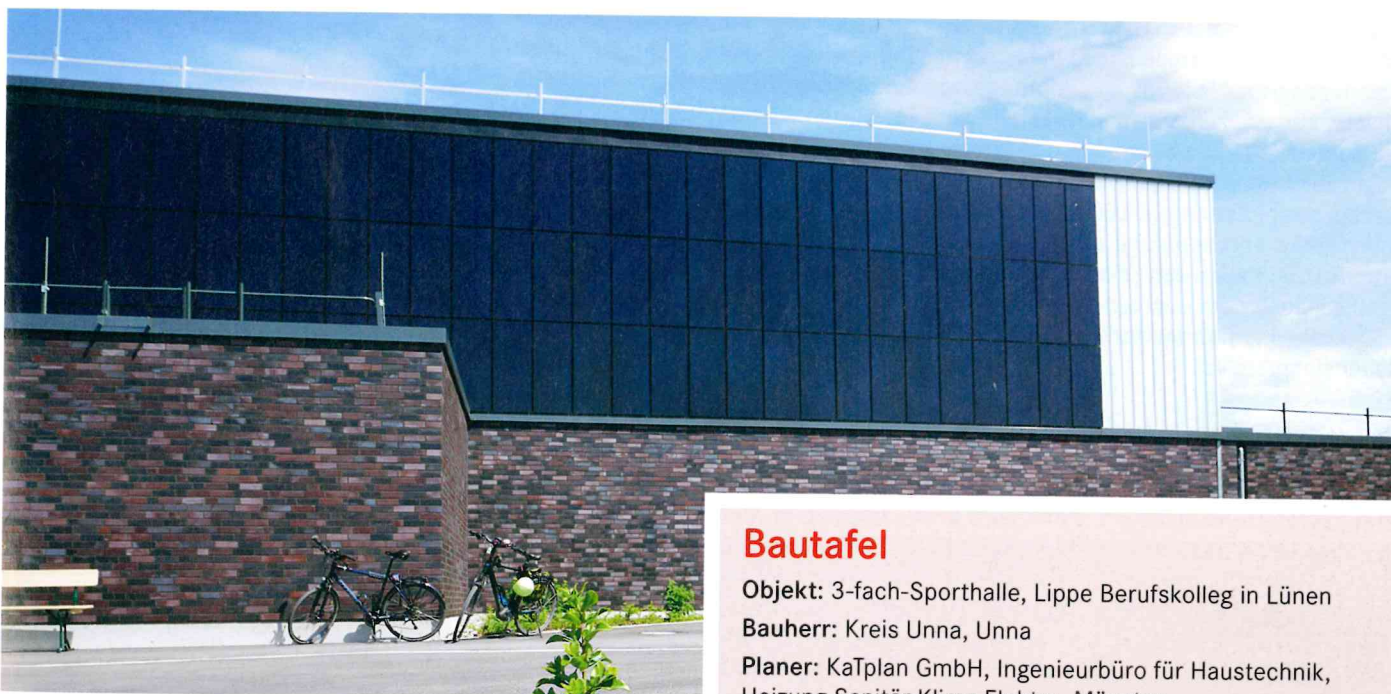
Außen fällt die sanierte Sporthalle des Lippe Berufskollegs in Lünen durch ihre Photovoltaik-Fassade auf.
