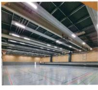
Mit der wasserführenden Deckenstrahlplatte KSP LED Premium erhält jede Halle eine hocheffiziente und langlebige Ausstattung. Dies liegt an der ausgefeilten Konstruktion: Sie stellt eine thermische Entkoppelung der warmen Strahlfläche und grundsätzlich wärme-
