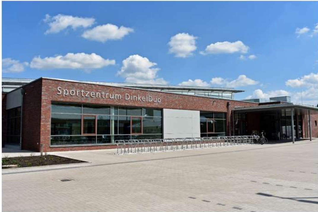
Die beiden Hallenteile mit ihren Sportfeldern befinden sich rund 3,25 Meter unter dem Geländeniveau.
