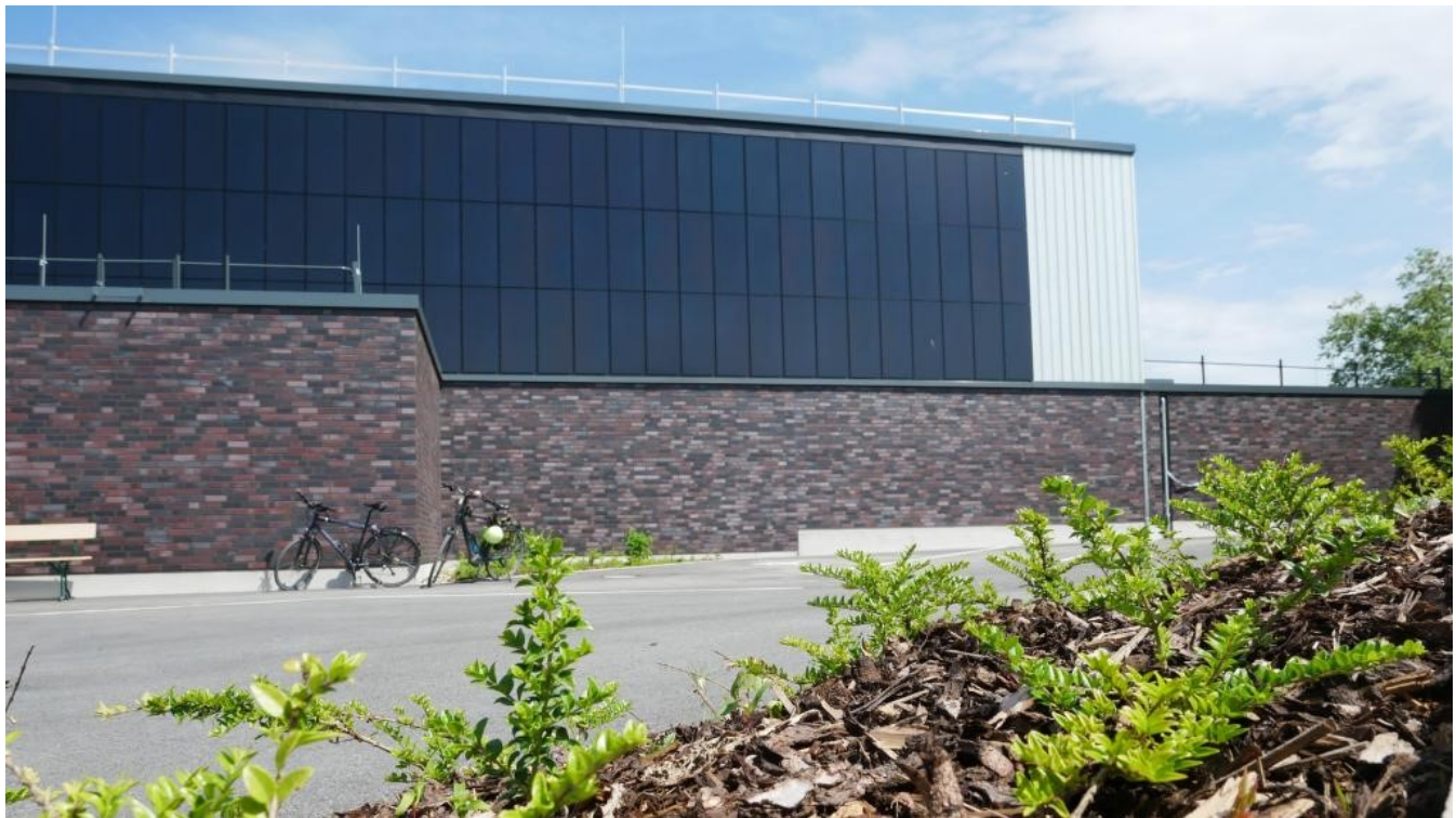
Die sanierte Dreifach-Sporthalle des Lippe Berufskollegs in Lünen.
