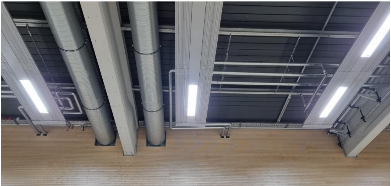
Die neue Deckenkonstruktion mit Deckenstrahlheizung und integrierten LED-Leuchten.
