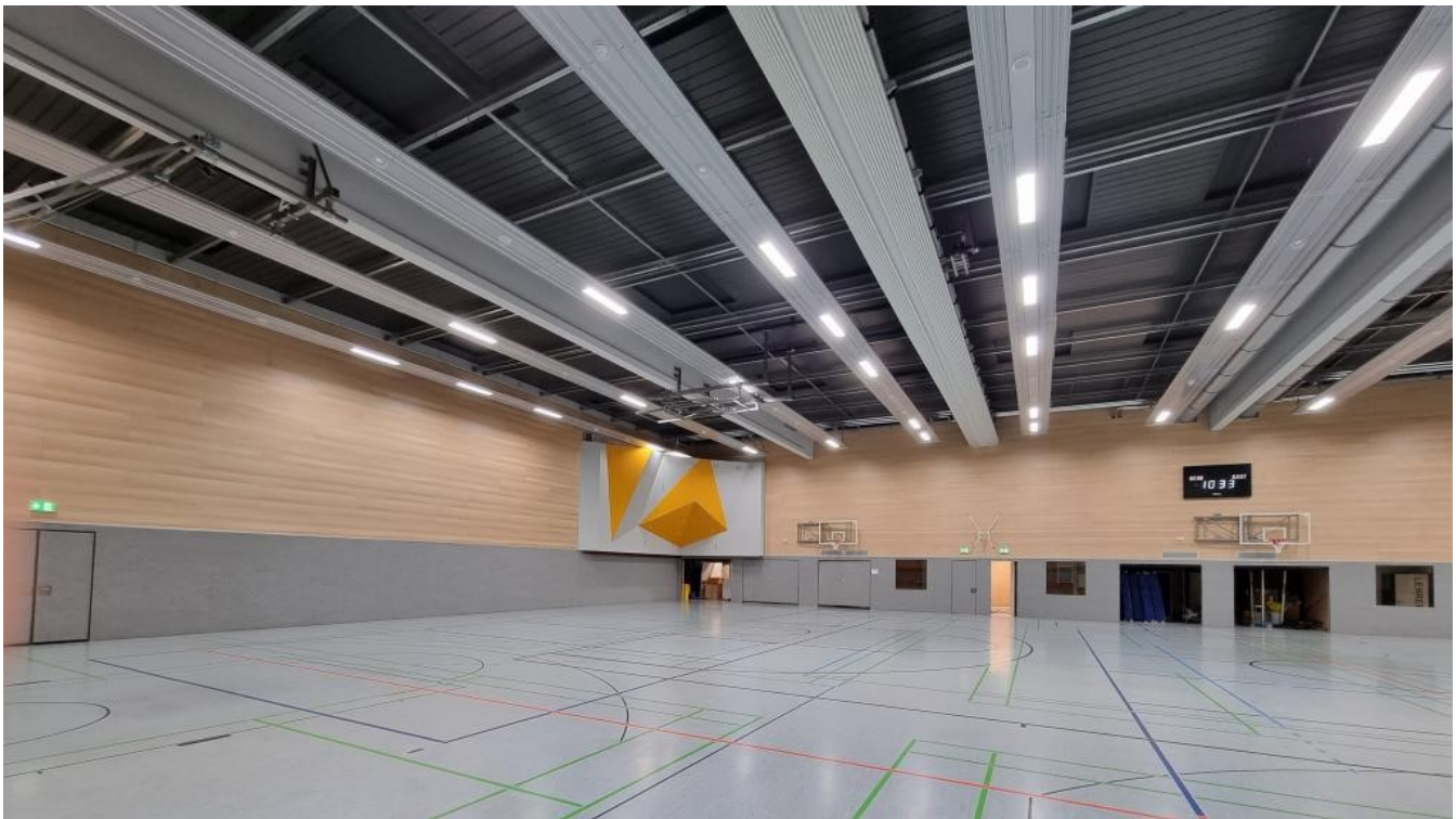
Die neue Sporthalle von innen.
