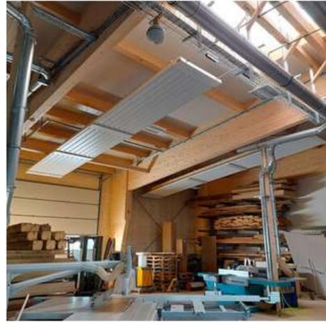
So kann das in der Praxis aussehen: In dieser Tischlerei (Schreinerei) sind die Deckenstrahlplatten aus dem Baukastensystem KSP to go im Einsatz. - © RMBH GmbH, Herrieden
