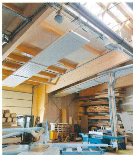
So kann das in der Praxis aussehen: In dieser Tischlerei sind die Deckenstrahlplatten aus dem Baukastensystem KSP to go im Einsatz.
