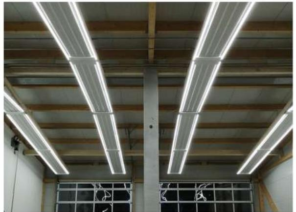
Bei einer Schrägmontage der Deckenstrahlplatten lassen sich die LED-Leuchten jetzt ganz einfach fixieren
