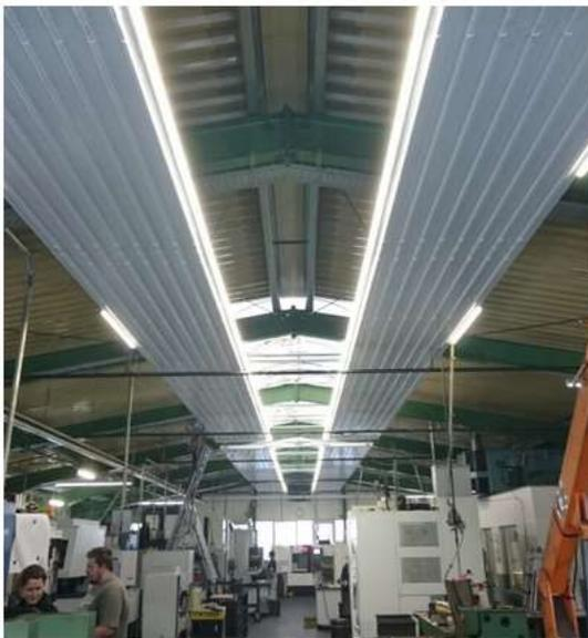
LED-Leuchten können an den Deckenstrahlplatten flexibel eingesetzt werden – einseitig, beidseitig, einzeln oder zu Lichtbändern verbunden
