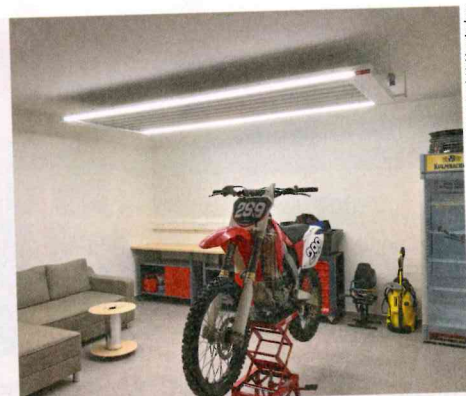
Die Deckenstrahlplatten aus dem Baukastensystem KSP to go werden zukünftig mit Regelungskomponenten ergänzt.
