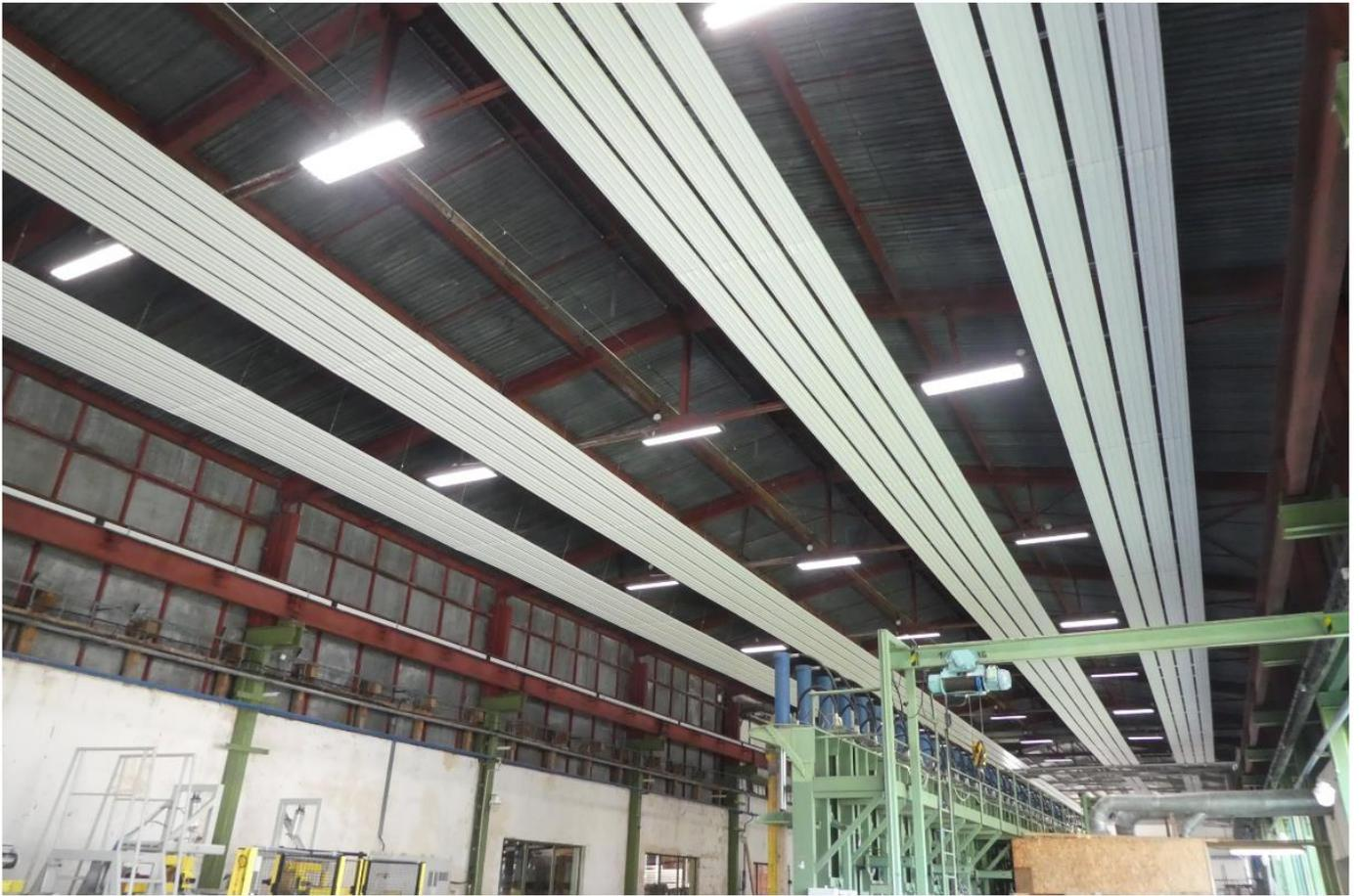
Eine Halle wurde mit Radia Expert<sup>®</sup> KIT ausgestattet – aus der 330 mm breiten KIT I sind vor Ort 1.500 mm breite KIT-IV-Elemente entstanden.
