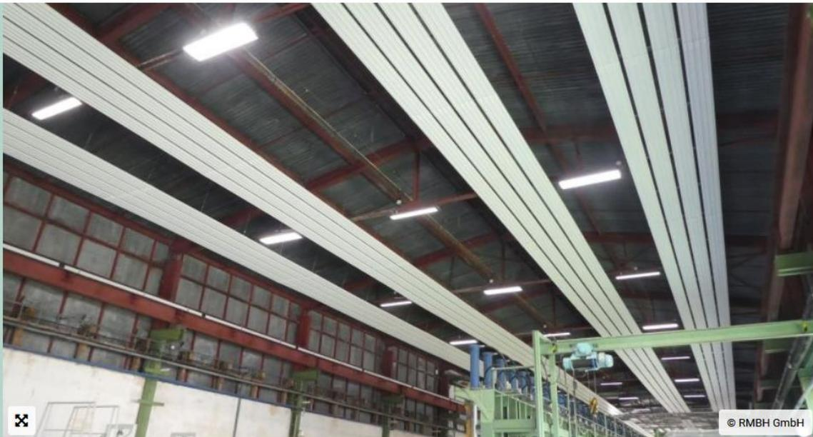
Eine Halle wurde mit Radia Expert KIT ausgestattet – aus der 330 mm breiten KIT I sind vor Ort 1.500 mm breite KIT-IV-Elemente entstanden.
