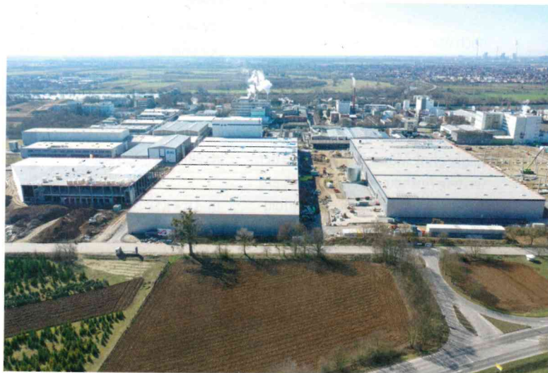
Bild 6 • Noch in der Bauphase: Ladenburg wird als Lager- und Distributionszentrum für Kunden in der Region genutzt.
