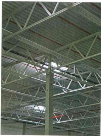
Bild 3 • Durch die geringe Aufbauhöhe von 50 mm kann jedes Strahlband in die Konstruktion eingefügt werden.
