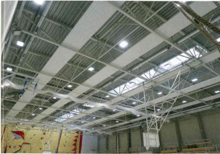
Flexibilität bei der Installation: Die Deckenstrahlplatten lassen sich in nahezu jede Dachkonstruktion einfügen.
