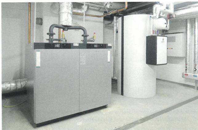
**Eine Zweier-Kaskade und ein Pufferspeicher mit Frischwasserstation bilden das Herzstück der Heizungsanlage.** Foto: RMBH GmbH
