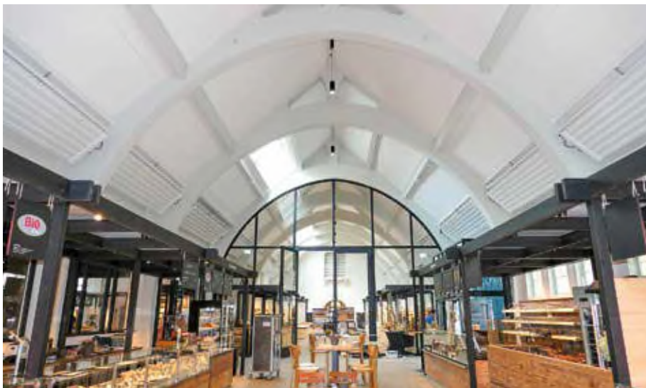
Exakt ausgelegt und in der Schräge montiert: Die Deckstrahlplatten erwärmen die Markthalle in Herford.
