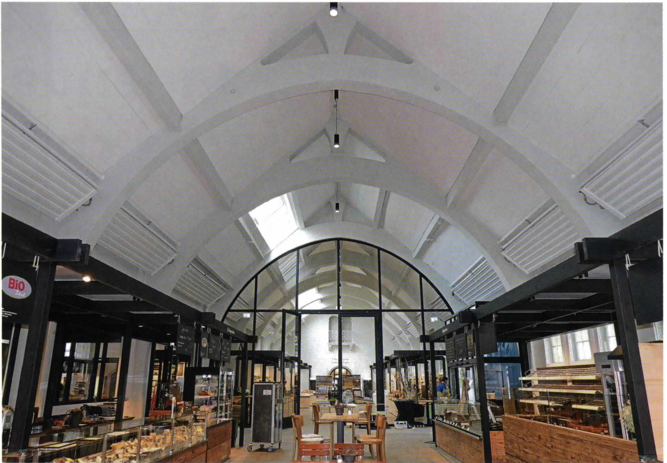
Der helle Innenraum der Markthalle wird durch Glasabtrennungen in mehrere Abschnitte geteilt. Die Deckenstrahlplatten Ksp-Akustik wurden hier jeweils in die Zwischenräume der tragenden Konstruktion installiert.
