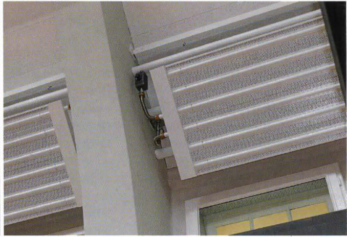
Die Aufhängung in der Schräge wurde mit U-Profilen aus Stahl und dem bewährten Drahtseilssystem Gripple umgesetzt. Der Platz für Anschlüsse und weitere Bauteile war limitiert. Vor- und Rücklauf sind mit flexiblen Schläuchen ausgeführt, zum Schluss wird die Abdeckung aufgesteckt.
